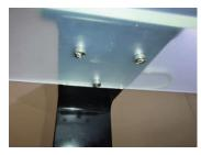
安装口水罩 (接上口水罩警报灯后, 使用3颗M8\*18内六角螺丝 对口水罩进行安装固定)
